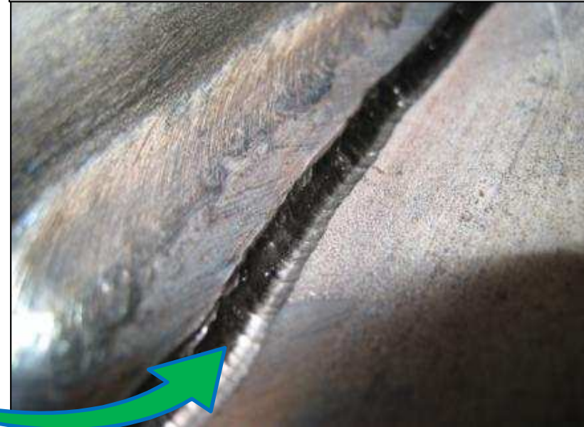
Door PIT behandeling geometrisch verbeterde overgang
